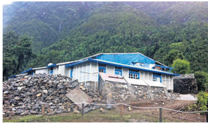
L'Hôpital de Lukla dans sa partie rebâtie. Plus de pierres sèches, mais des murs en aggloméré, pas dangereux en cas de séisme. DR
